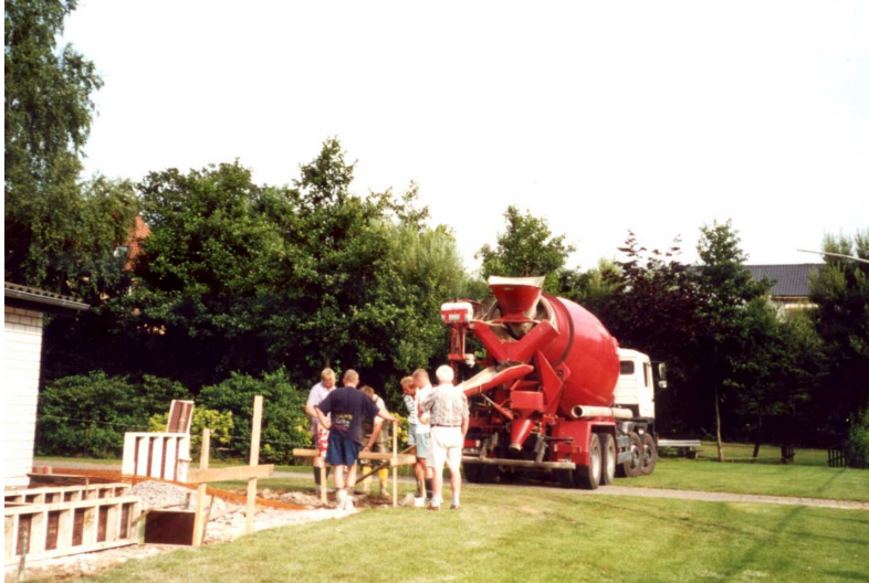
es wurde ausgeschachtet und Beton bestellt
