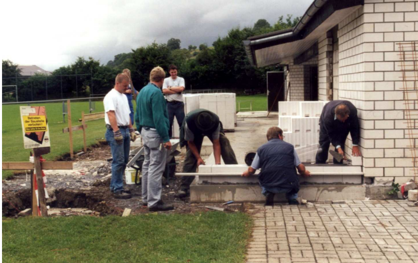
die ersten Steine werden gesetzt
