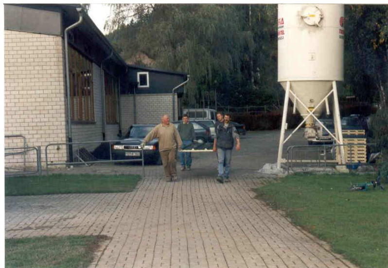
Dachplatten werden herangetragen...
